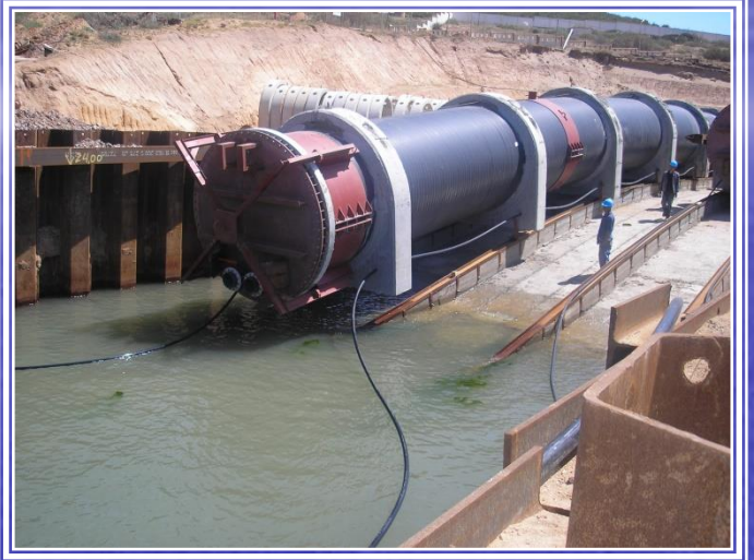
Rampa de lanzamiento de la planta desaladora de Beni-Saf (Argelia) Di=2.400 mm
