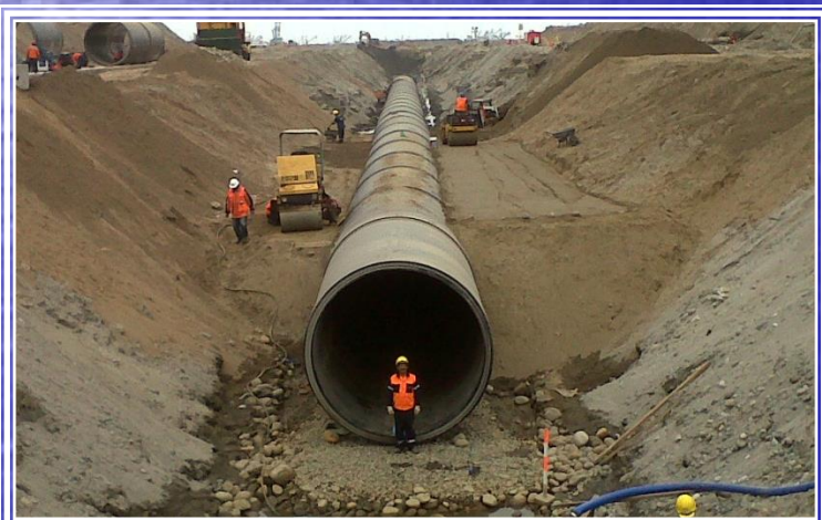
Emisario Submarino de La Taboada (Lima, Perú). Di= 3.000 mm
